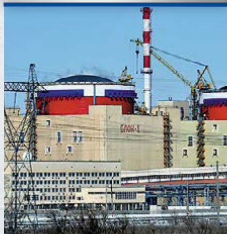
Введены в эксплуатацию 341,8 км линии ВЛ 500 кВ Ростовская АЭС - Тихорецк
