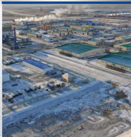
Введена в эксплуатацию вторая цепь высоковольтной линии между Уренгойской ГРЭС и нефтяными месторождениями протяженностью 426,87 км
